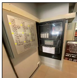
ภาพที่ 2.1-14 ระบบแจ้งเตือนเหตุเพลิงไหม้
